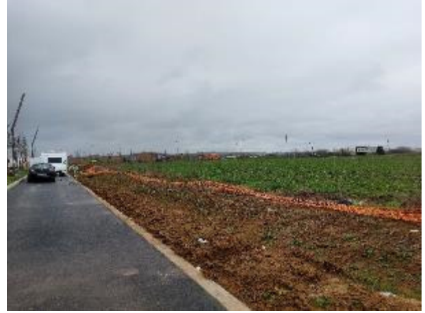
Photo 4 : vue depuis la rue du Champ Moreau vers l'angle sud-est
