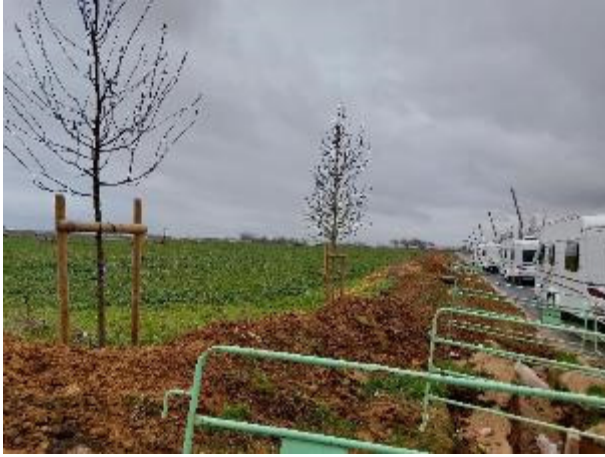
Photo 3 : limite nord du terrain, rue du Champ Moreau depuis l'intersection avec la rue de la fosse aux loups
