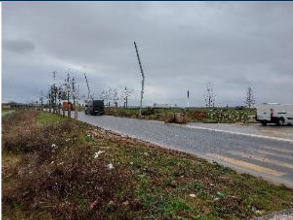
Photo 1 : angle nord-est du terrain, vue depuis la l'intersection rue de la fosse aux loups et de la rue du Champ Moreau
